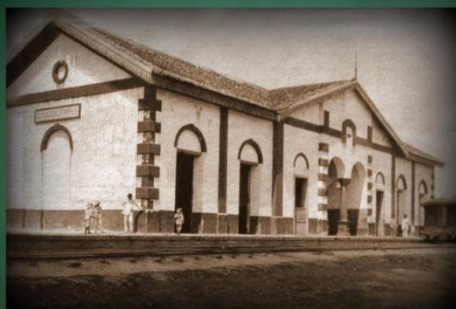
Complexo da Refesa Estação Engenheiro José Lopes, 31 de dezembro de 1922.
