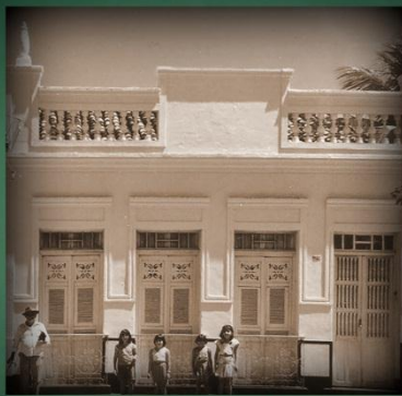
Casa da Marta Becco, demolida em 2015.
