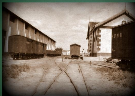
Complexo da Refesa Estação Engenheiro José Lopes, 31 de dezembro de 1922.
