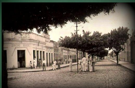
Outro trecho da Avenida Santos Dumont. Década de 1940. Em destaque, a loja "A Brasileira", de Quintino Brasil, onde também funcionou o Bar do Dedé Brasil e Empresa Redenção, respectivamente.
