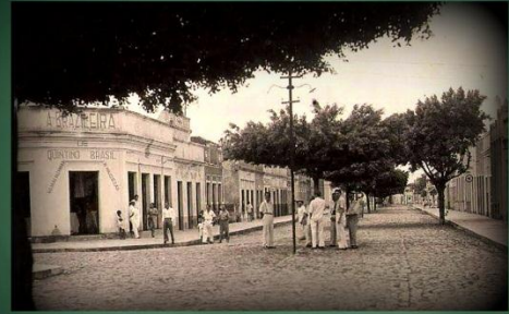
Outro trecho da Avenida Santos Dumont. Década de 1940. Em destaque, a loja "A Brasileira", de Quintino Brasil, onde também funcionou o Bar do Dedé Brasil e Empresa Redenção, respectivamente.
