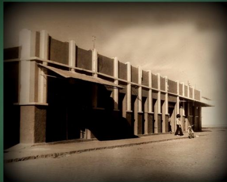
Prédios Comerciais da Avenida Santos Dumont, possivelmente antigo mercado.
